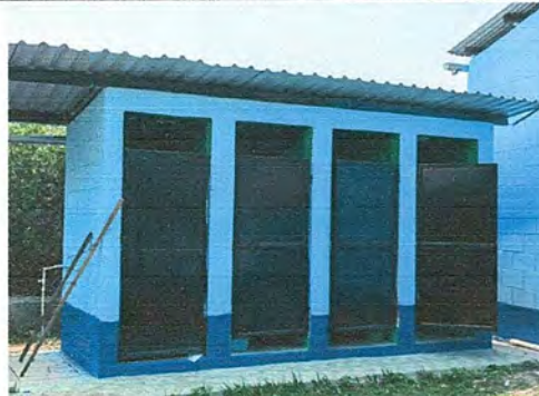
Foto 2: Finalización de modificación servicio sanitario, pintura interior y exterior, techo, puertas, piso
