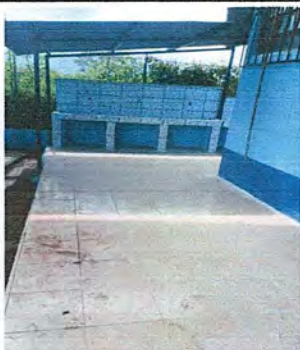
Foto 3: Finalización de mejoramiento de piso y lavamanos.
