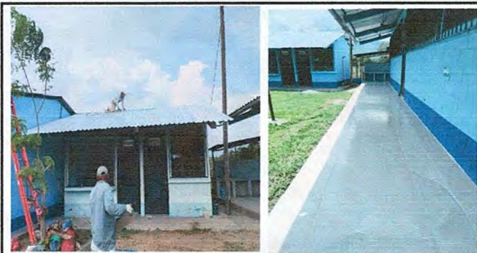
Foto 5: Cambio de techo de cocina y dirección y pintura en paredes, anticorrosivo en balcones y puertas. Finalización de mejoramiento de piso y lavamanos
