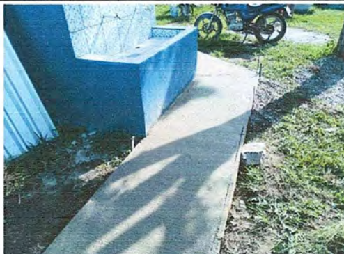
Foto 4: Finalización del abastecimiento de agua, azulejado para evitar inundación y banqueta adicional
